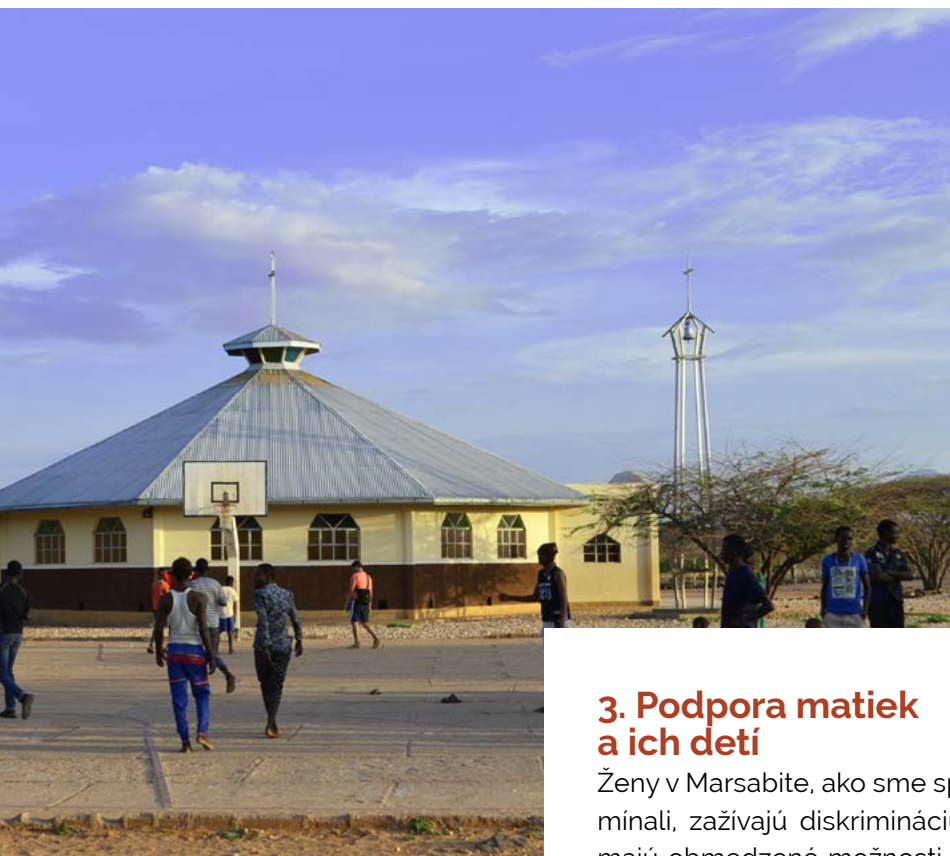
Basketbalové ihrisko pri saleziánskom dome využíva množstvo mladých, je však potrebná rekonštrukcia. Foto: © Adriana Mahdalová
